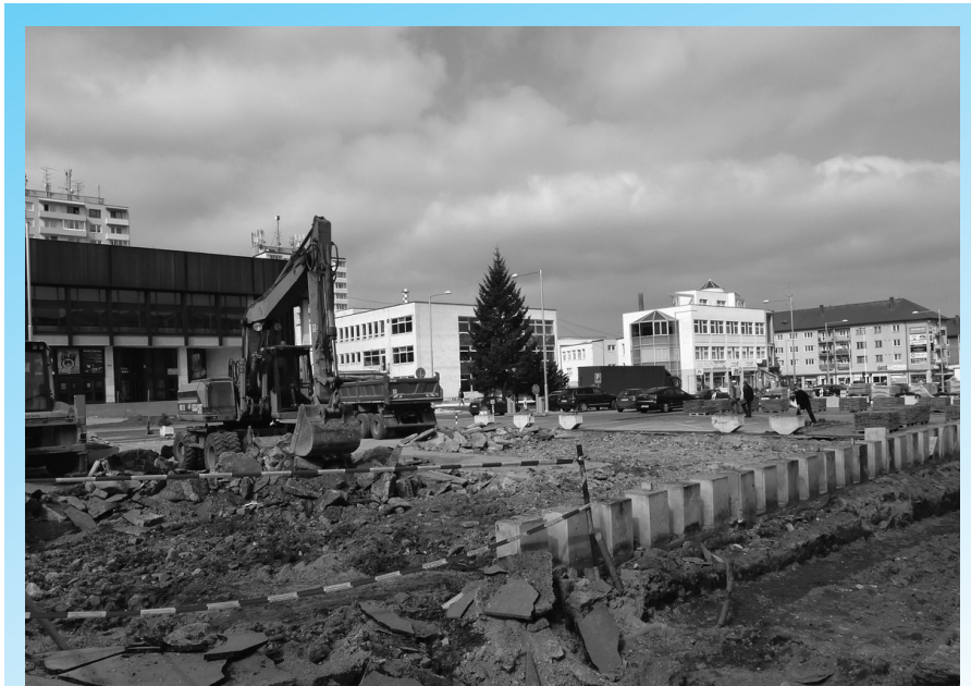
Ťažké mechanizmy pripravujú ďalšiu časť námestia na rekonštrukciu podľa projektu Senica s novým námestím.
