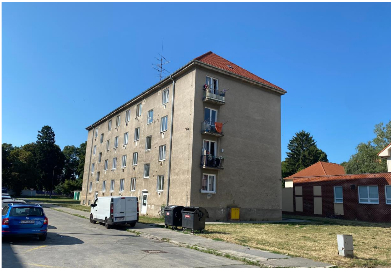
Bytový dom Janka Kráľa s. č. 734 na pozemku E-KN parc. č. 534/1 k. ú. Senica – pohľad zadný.
