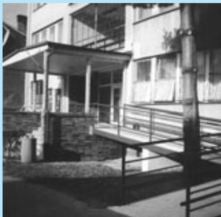
Vstup do budovy OO PZ v Senici.
