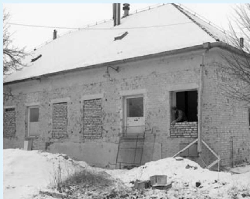
Jedna z budov v bývalom vojenskom priestore prechádza stavebnými úpravami.
