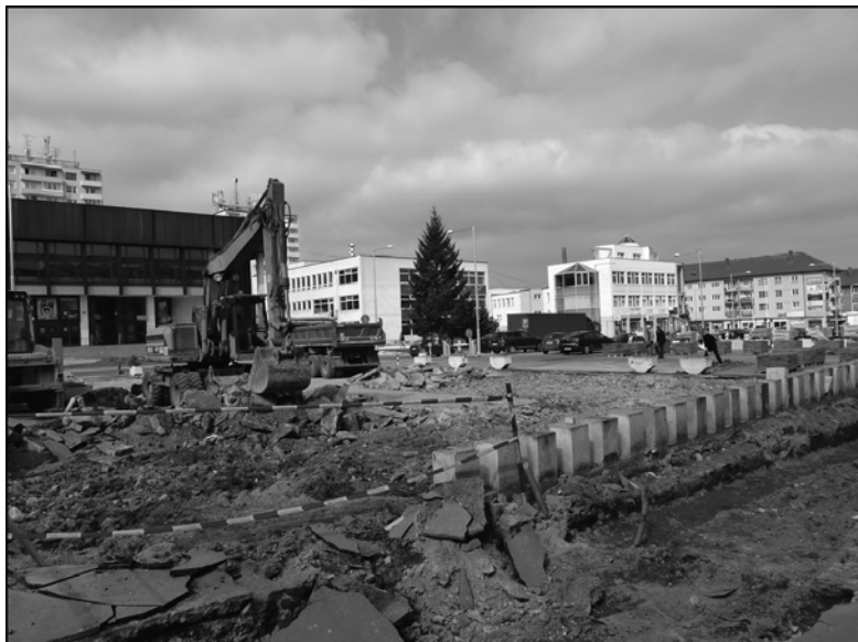
Ťažké mechanizmy pripravujú ďalšiu časť námestia na rekonštrukciu podľa projektu Senica s novým námestím. Foto Viera Barošková
