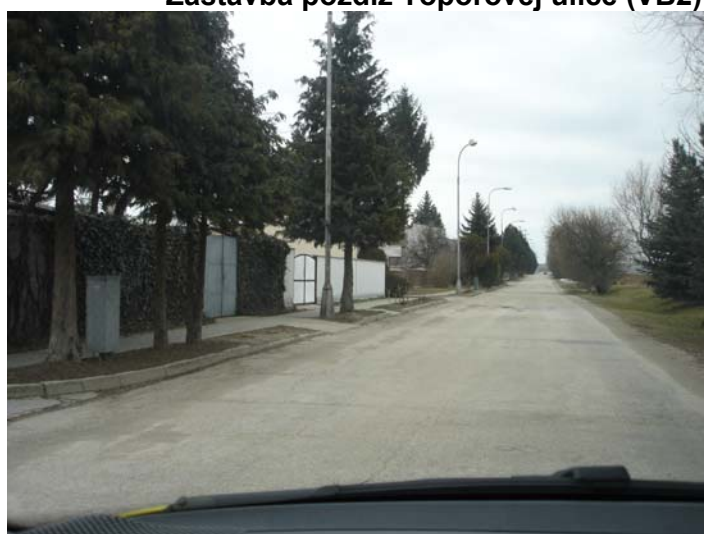
Zástavba pozdĺž Topoľovej ulice (VB2):
