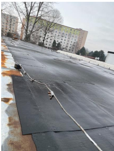
Plochá strecha prevádzkovej budovy
