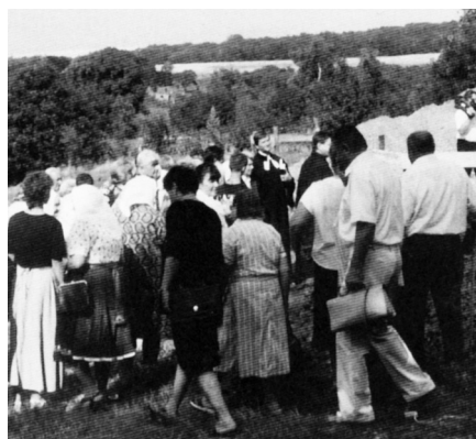
Kladenie základného kameňa Domu smútku.
